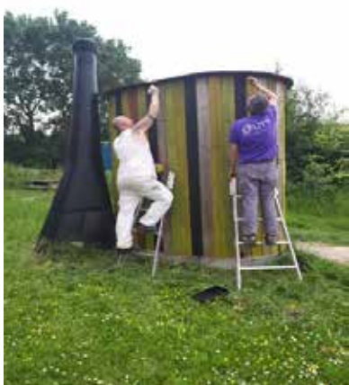
Peinture et rénovation de façade
